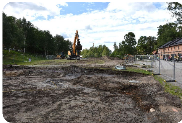
Pågående arbete med gräsytor som sanerats under 2019. Vy mot väster. Foto: WSP.
