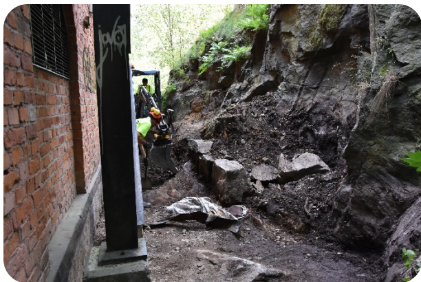
Svåråtkomligt arbete bakom restaurangbyggnad. Foto: WSP.
