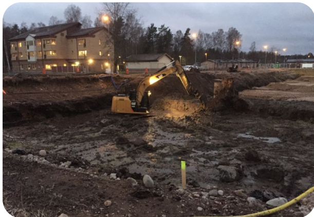
Bild från pågående sanering vintern 2018–2019. Foto: Peter Ferenzy.
