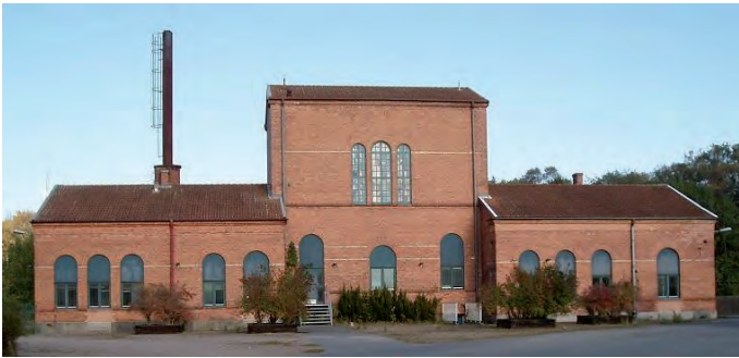
Gasverket i Kristianstad före och efter påbörjad sanering.
