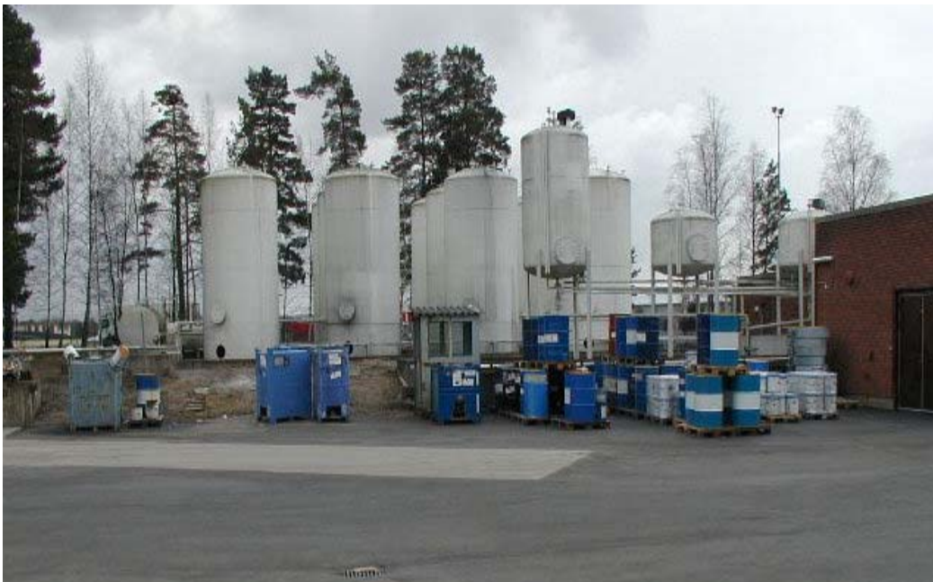
Foto 2. Exempel på cisternpark på större, modern färgfabrik. Notera dagvattenbrunnen.
