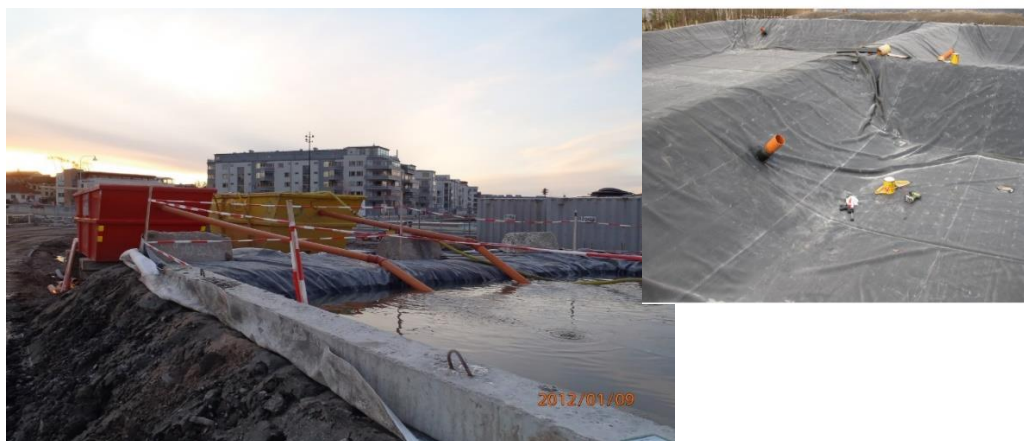
Figur 3.3 Sedimentationsdamm till vänster och uppbyggnad av damm med flera uppsamlingstråg till höger. Foto. A-C. S. Lember
