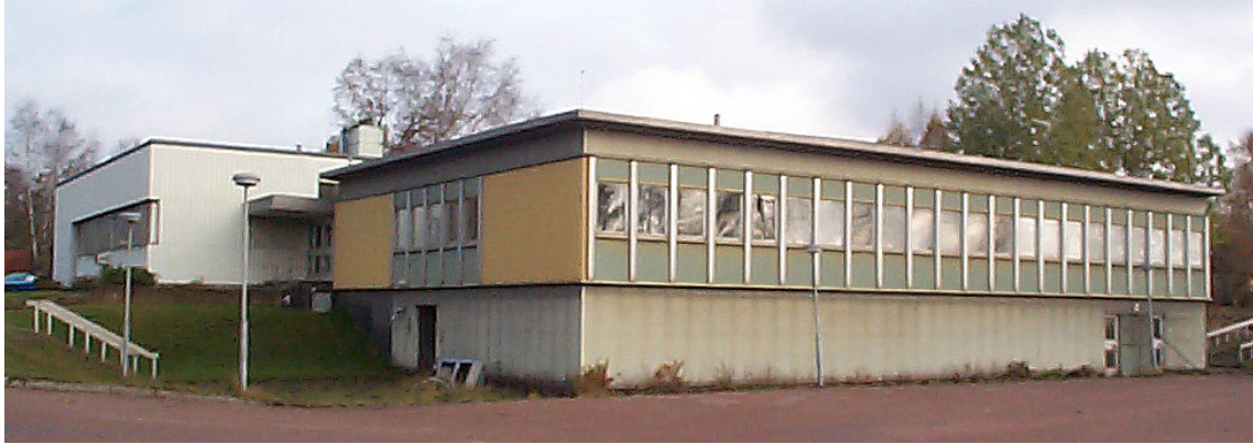
Kontorsbyggnaden med laboratoriet bakom.
