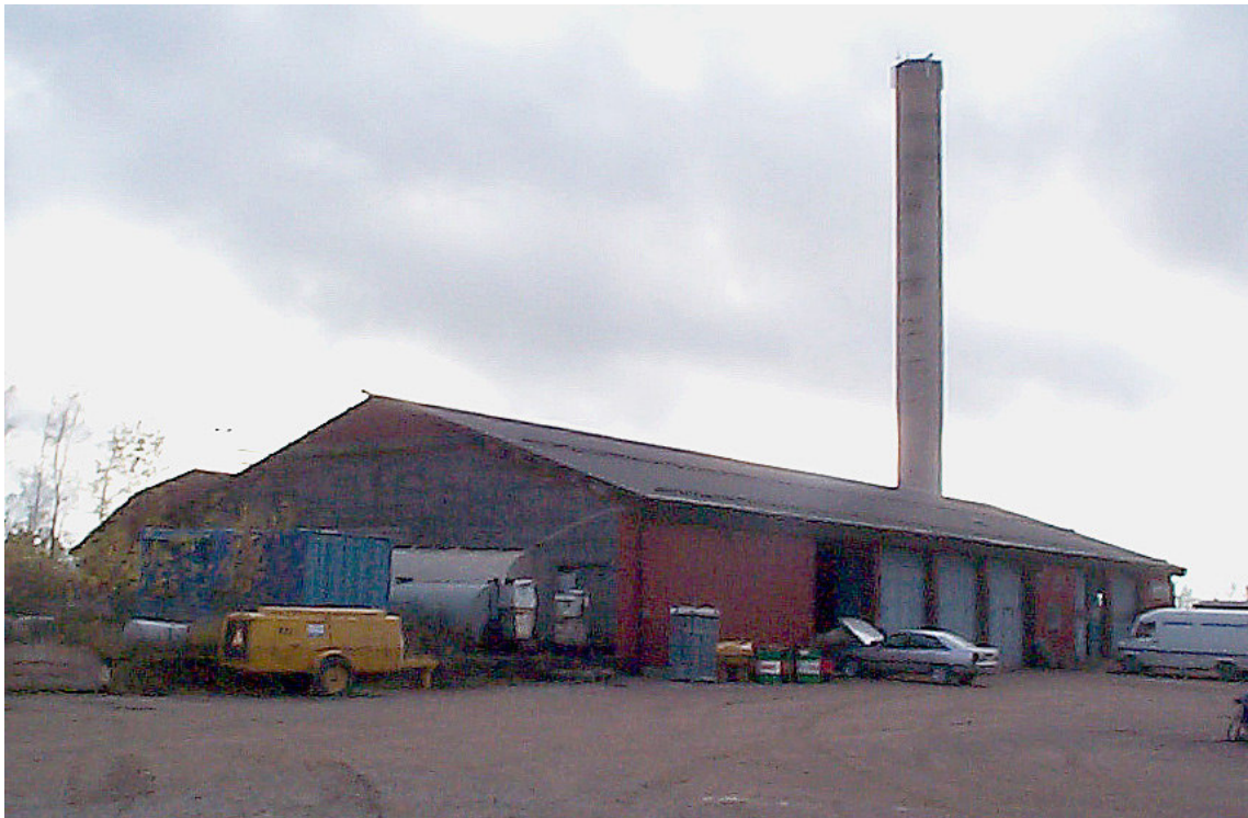
Det gamla saltmagasinet.
