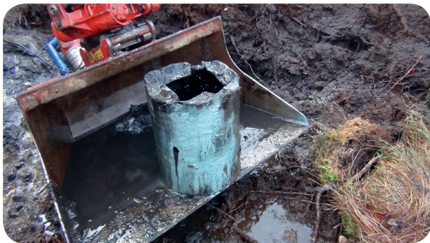
Uppgrävd tunna Foto: Golder
