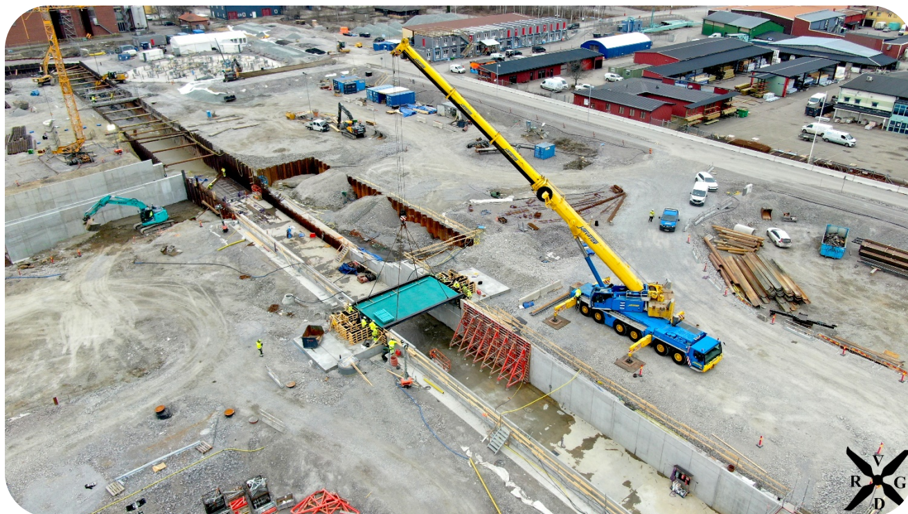
Översikt av Inre hamnen där anläggning av de nya kanalerna och lansering av den första bron kan ses. Den termiska behandlingen av lilla gasklockan syns i bakgrunden. Foto: Runar van Geffen.
