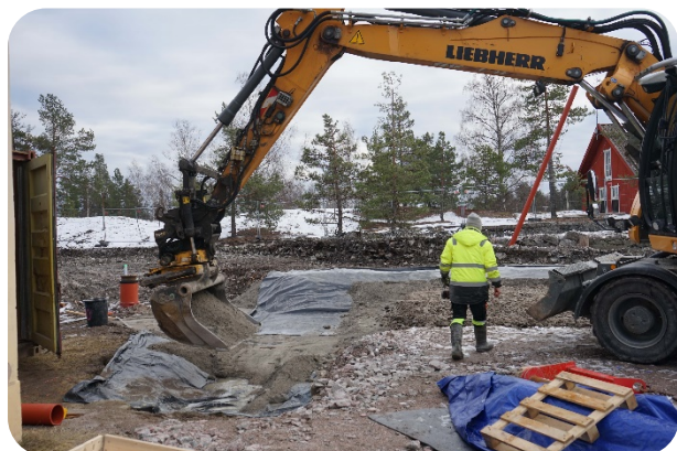
Marken vid centrala gruvområdet jämnas till och täcks med en bentonitduk och rena massor. Foto: Ulrika Larson.
