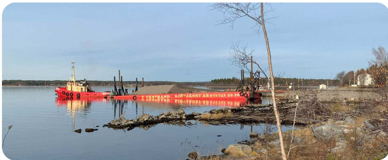
Inlastning av grusmaterial med pråm. Foto: Umeå kommun.
