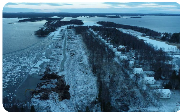
Rivning av stenkistor. Foto: Umeå kommun.
