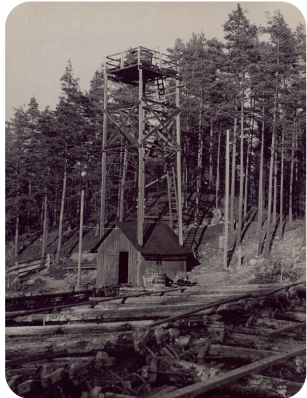
Björkhult runt år 1900. Högst upp i tornet syns behållaren för kopparvitriollösning. I nederkant ses impregnering av stolpar på rad, varje stock med påkopplad platta för tillförsel av kopparvitriolen. Foto: Televerkets samlingar via Digitalt museum.
