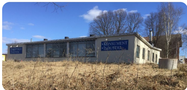
Enköpingstvädden, byggnaderna är idag rivna. Foto: Stefan Nyström
