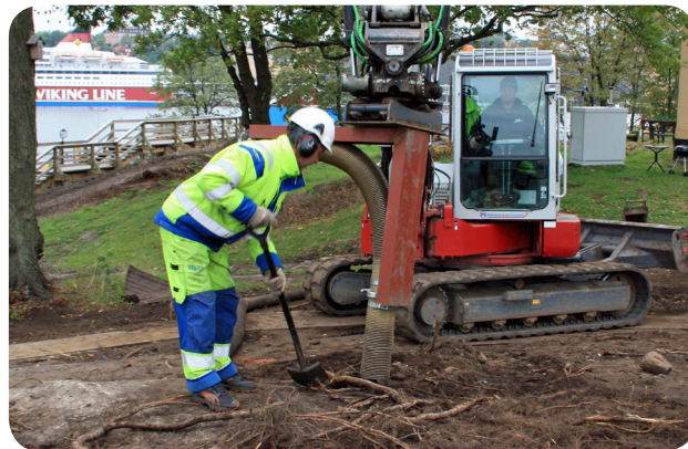
Vakuumschaktning bland trädrötter på Beckholmen Foto: Christer Egelstig
