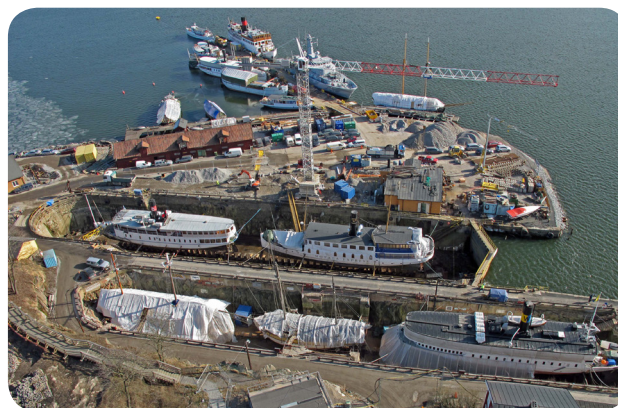
Marksanering pågår på varvet. Foto: Erik Söderberg
