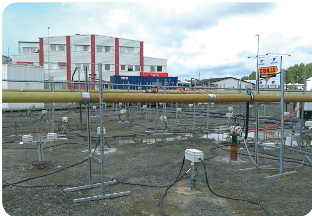
Pågående in situ-sanering på Bomgatan i Kristianstad. Foto: Johan Wigh.
