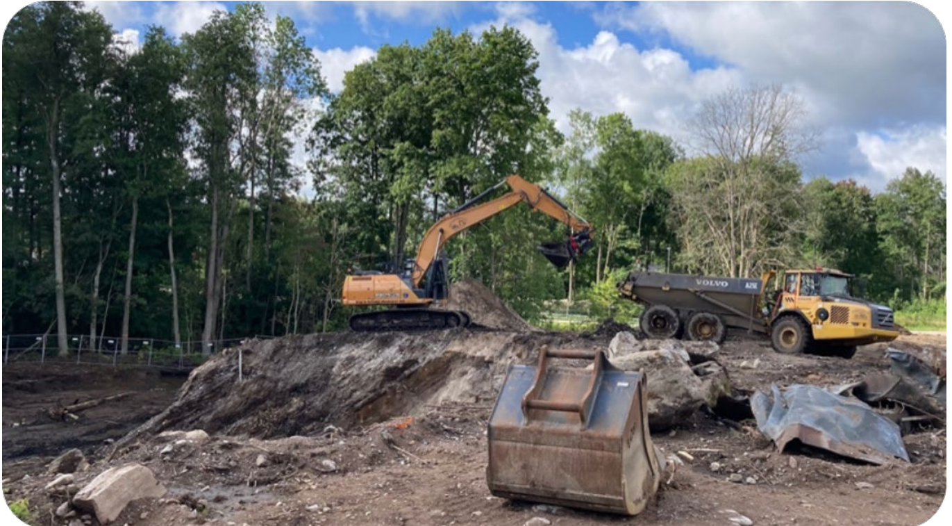
Saneringsentreprenad Flerohopp glasbruk hösten 2021. Foto: David Lokrantz.
