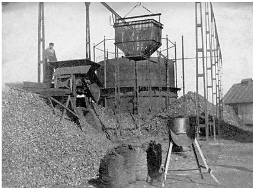
Traversbana för koks. Anordning för att fylla koks i säckar. I bakgrunden syns gasklockan.
