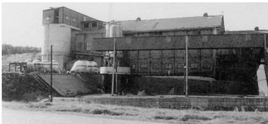
Anrikningsverket som det såg ut strax innan nedläggningen 1993. Till vänster malmfickor. Den stora byggnadskroppen är flotationsverket. Framför denna ligger sligupplagen. Byggnaderna revs 1995.
