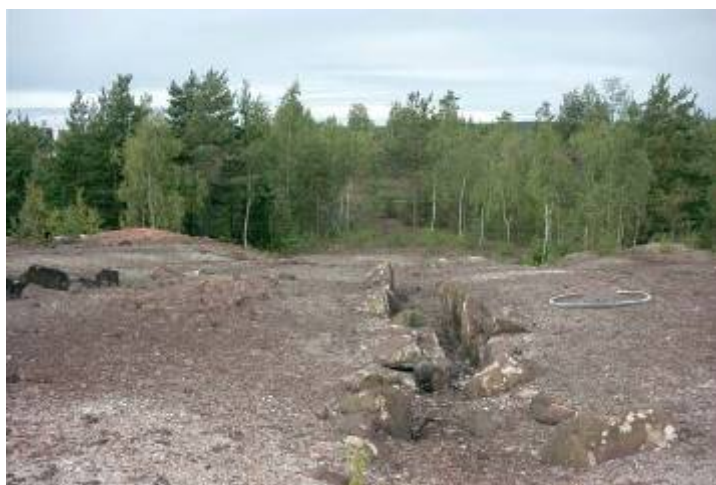
Kallrostlämningar vid Syrafabriksvägen Här syns de 20 meter långa svavelkanalerna bakom själva kallrosten dit svaveldioxiden leddes. Kanalerna var täckta med stenar eller bräder. Här kondenserades "droppsvavel". Vid skogskanten stod "blomhuset" där svavelblomma avsattes. Se även bild på sidan 10.
