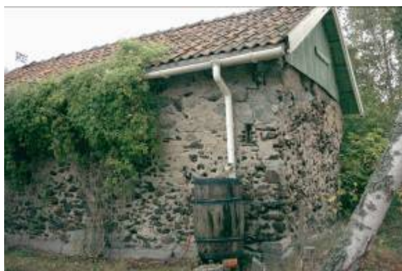
Foto av uthus gjutet med slaggsten i Bergsgården. Man kan fortfarande se formbrädorna i putsen.
