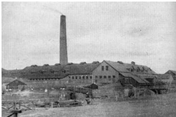
Bild på "Utlakningen" vid Hanröbron från 1890-talet. Skorstenen gjordes hög för att föra bort svaveldioxiden så långt som möjligt. Som synes började skorstenen luta redan under uppförandet. 1920 vågade man inte ha kvar hela skorstenen varför den förkortades betydligt.
