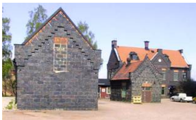
Byggnader söder om gruvan, av gjutna slaggblock från Kopparverket.
