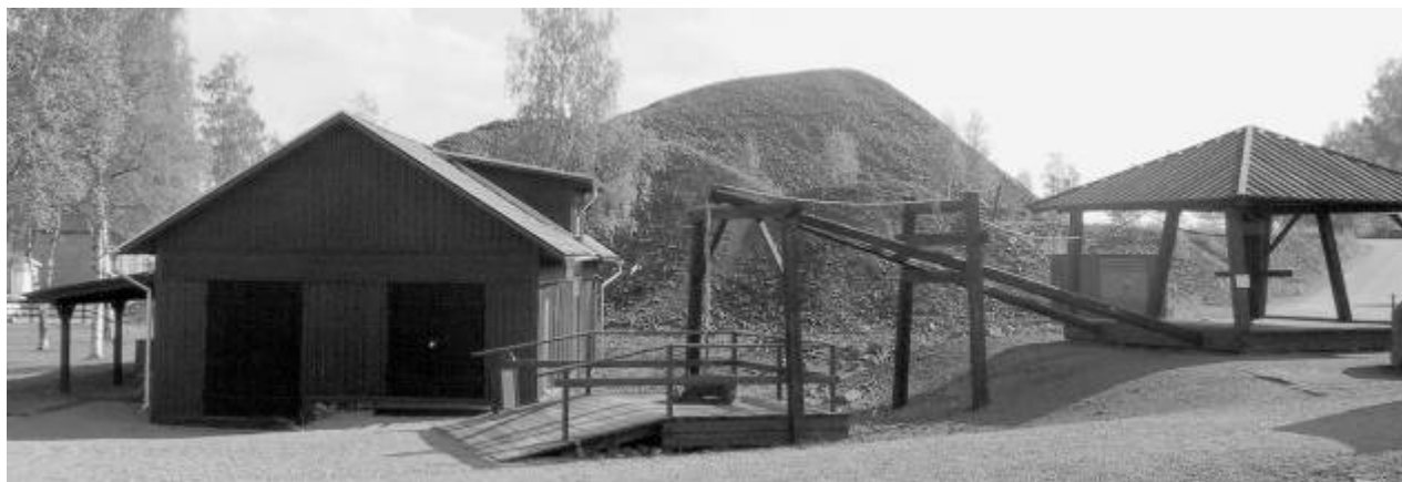
Varphög vid Gruvmuseet. Här lades gråberget upp sedan malmen vaskats (anrikats) i vaskverket i förgrunden – för övrigt det enda i Sverige med bevarade maskiner. Högen var förr betydligt större, vilket kan ses på äldre fotografier.
