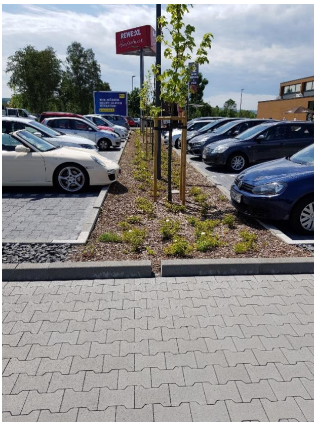
Figur 6b. Exempel på genomsläpplig beläggning och svackdike med rosplantering på parkeringsplats i Koblenz, Tyskland (foto: Sweco)
