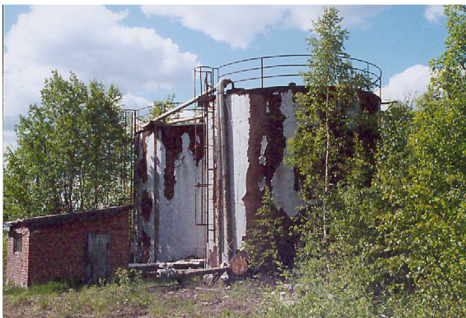
Oljecisterner av järn nordväst om fabriksbyggnaderna.
