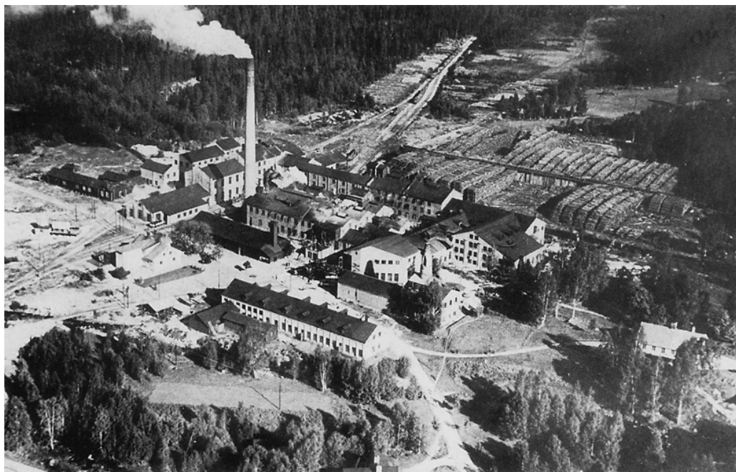
Vy över pappersbruket i Fredriksberg 1934. I förgrunden den mekaniska verkstaden. Sulfutfabriken bakom skorstenen och sulfatfabriken till höger om denna. Bakom fabrikerna syns det stora lagret av massaved med spelbana i mitten. På denna transporterades veden från Sågdammen till vedupplaget.
