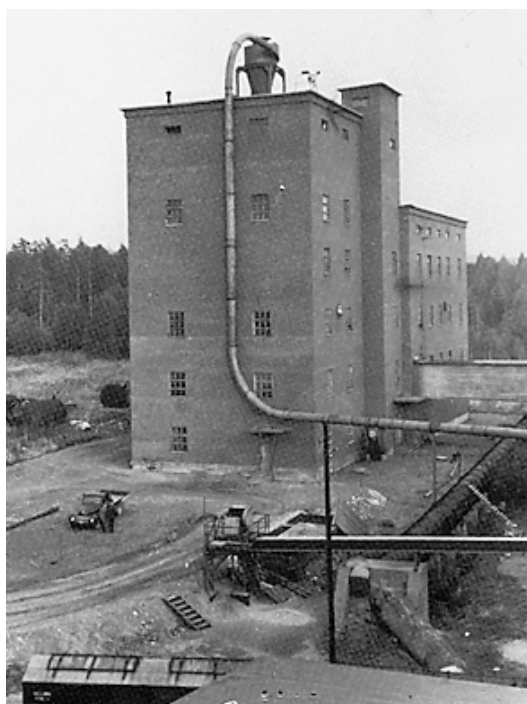
Sulfatkokeriet med blåsrör för flis. Flisfickan i förgrunden. Innehöll fyra stående kokare som rymde 85 kbm vardera. Massautbytet var ca 7 ton per kok. Byggnaden revs 1988.
