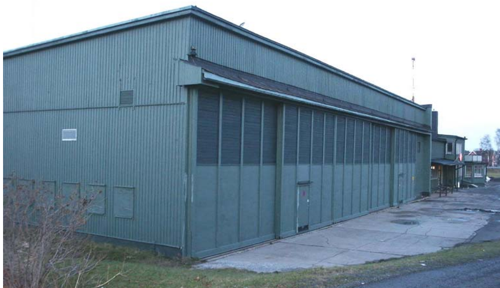
Figur 7. Före detta flyghangar vid Norrtälje flygfält, foto taget från sydväst. (Foto D. Lokrantz 2003).
