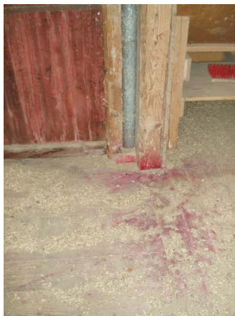
Bild 3: Betmedelsrester på golv och vägg.
