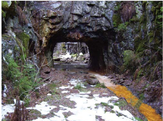
Bild 4: Metaller lakas ur gruvavfall och sprids med ytvattnet. Här i en gammal stollgång i ett gruvområde.
