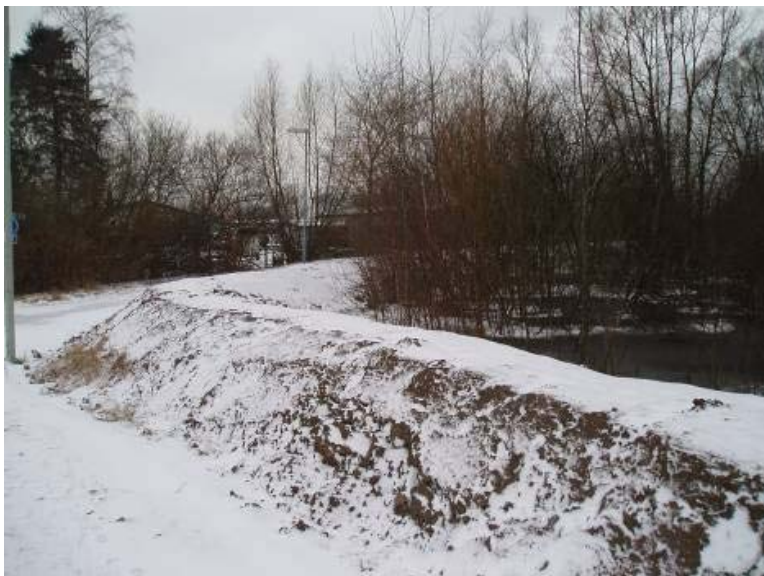
Förstärkt skyddsvall vid Bomgatan. Foto: Karin Jonasson 070212
