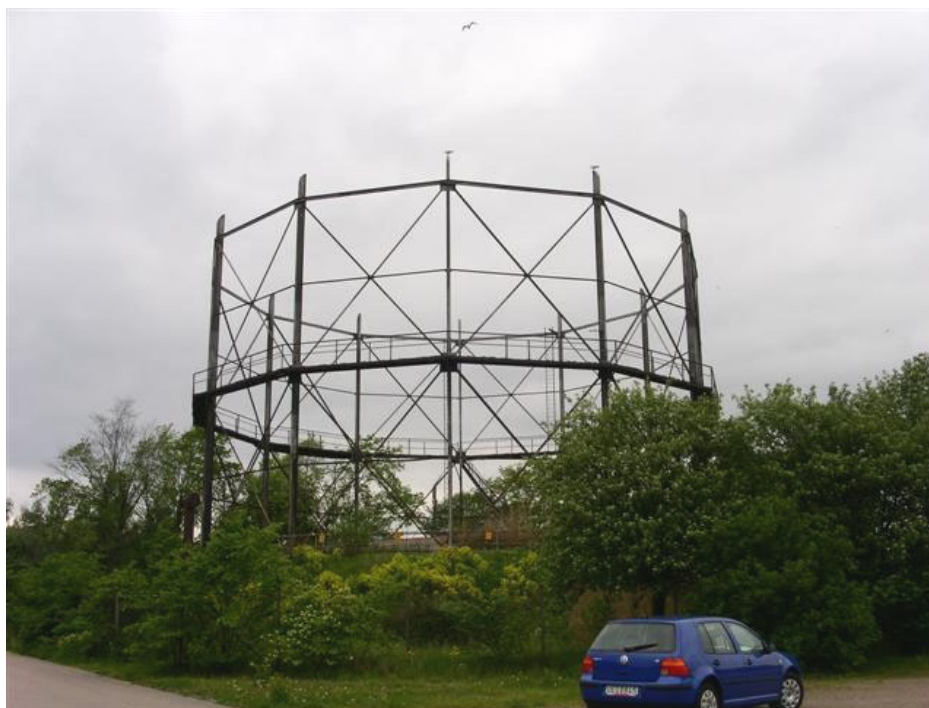
Figur 3. F d stora gasklockan inom kvarteret Viadukten.
