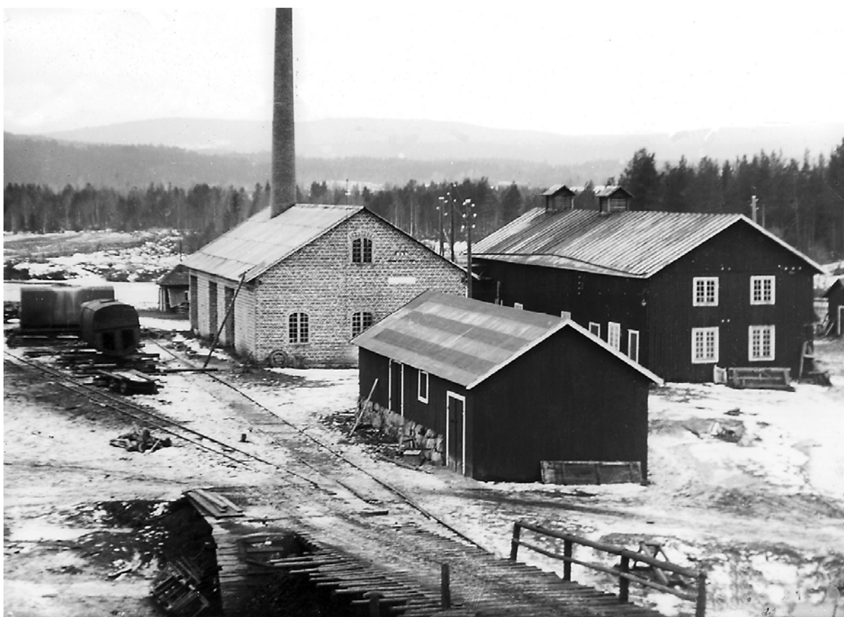
Figur 3. Voxna Träoljefabrik 1958. 2 st retortvagnar utanför retortugnshuset med 3 ugnar. Foto från Edsbyns museum (publicerad med Edsbyns museums medgivande).
