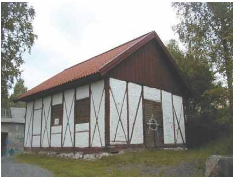
Figur 27. Klensmedja vid Krokfors bruk. Foto: Länsstyrelsen, Kulturmiljö
