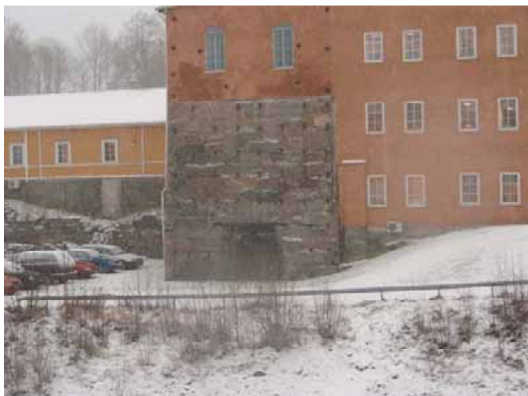
Figur 21. Dalkarlslytte bruks masugn inbyggd i den nuvarande lärocenterbyggnaden. Foto: Länsstyrelsen, Miljöskydd
