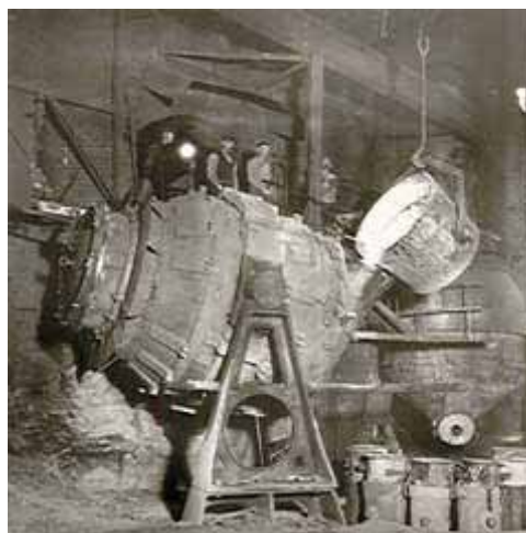
Figur 7: Bessemermetoden, konverter tappas. (Foto: www.jarnriket.com ).
