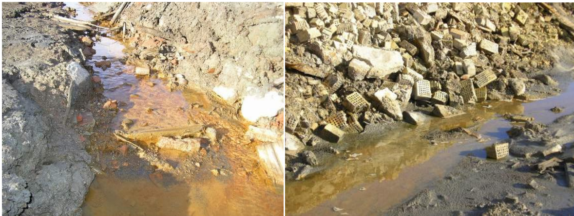
Bild 4.1 visar förorenade massor i lertäkt nr 4 och det stora vattenflödet i området. (Gleisner, 2005)
