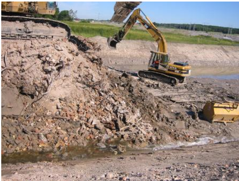
Bild 4.2 Täktområdet för Bergsbrunna Tegelbruk var mycket omfattande. Om man tittar i rak linje bakom grävmaskinen mot högspänningsledningen ser man ett torrt, brunt område med enstaka buskar. Det är den sista täkten för Bergsbrunna Tegelbruk, idag en stenig fårhage. (Gleisner, 2005)
