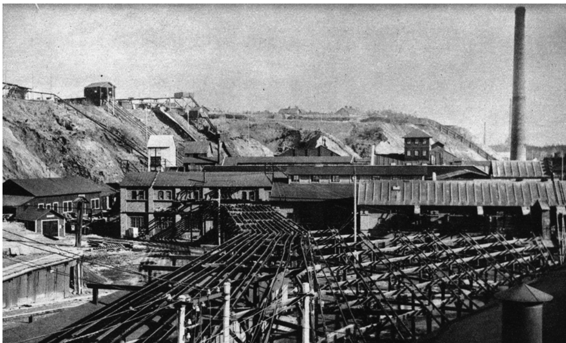
Anläggningarna vid Månsbo. I förgrunden syns de grova skenorna för överföring av den elektriska energin från kraftstationen till elektrolysbaden.
