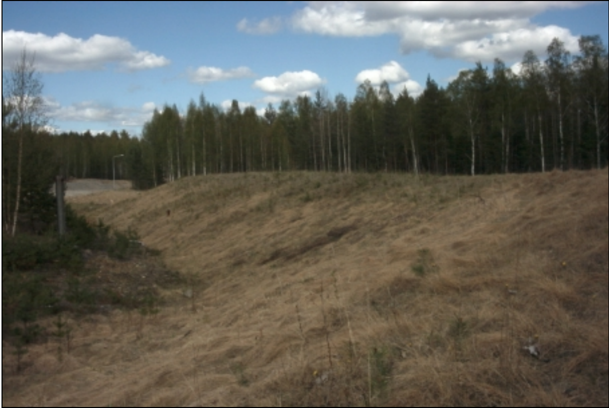
Figur 4.1. Norra delen av arsenikdeponin i Källviken. Bortanför deponin syns en del av nya Tallenleden.
