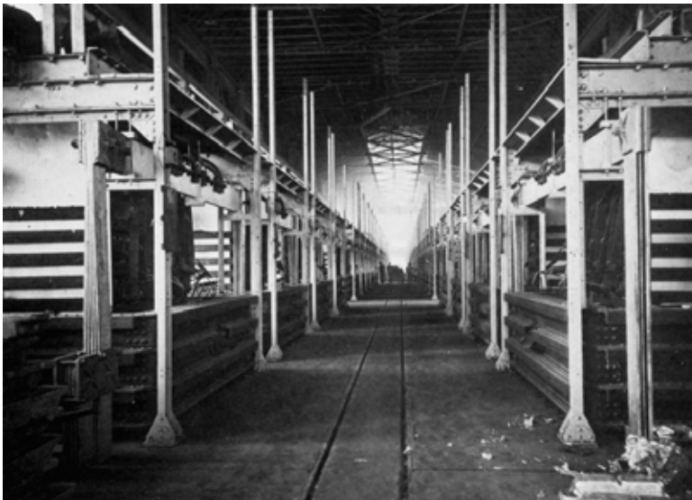
Figur 2. Ugnshall med 50 st oljeeldade smältugnar. Under perioden 1934-1964 bedrevs primärproduktion av aluminium inom aluminiumverket i Avesta. (Bild hämtad ur Rapport 2000:15. Länsstyrelsen i Dalarnas län. Aluminiumfabriken i Månsbo - industrihistorisk kartläggning med avseende på förorenad mark.)
