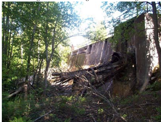
Den övre dammen. Rester efter en tub i mitten.
