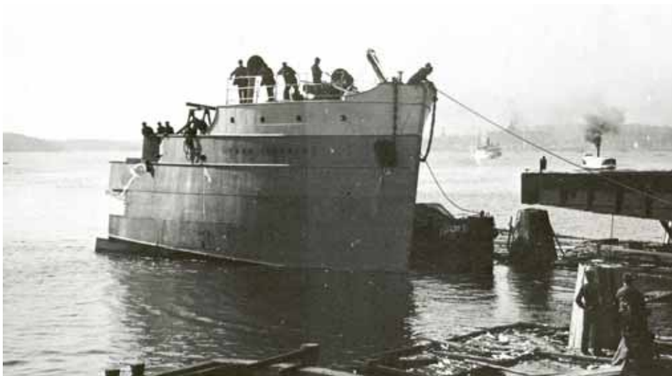
Figur 7. Förskeppet på ett ryskt fartyg byggt vid Bergsund, här passerandes järnvägsbron för att genom Slussen fortsätta ut i Saltsjön och sedan sättas ihop med akterskeppet vid Finnboda varv. Foto Anton Blomberg 1899.
